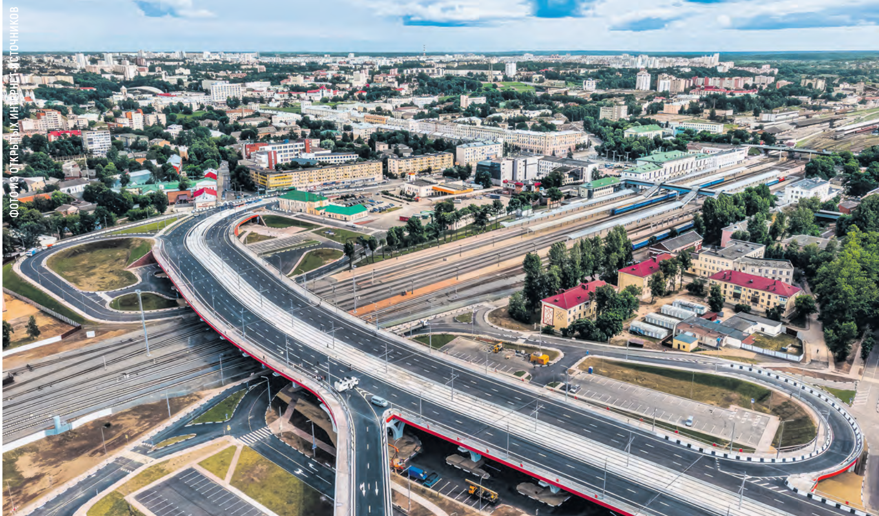
Путепровод «Полоцкий». Витебск.
